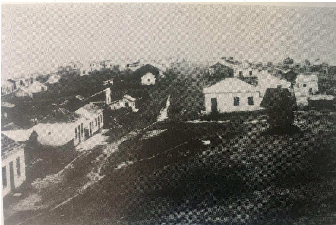
Figura 7 – 1919 - Rua de Cima. Arquivo Histórico Municipal de Osório.
